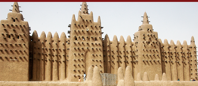
Mosquée de Djenné au Mali
